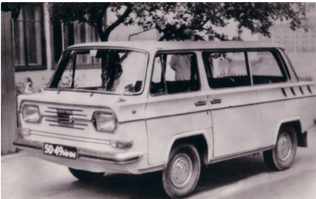
Автомобиль «Дружба» (Москва) Автор Н.Давыдов, фото И.Туревского Особенность конструкции: Кузов вагонной компановки с задним расположением двигателя. Мест – 5, коробка передач от ЗАЗ-968, двигатель – ВАЗ 2101, масса в снаряженном состоянии – 1000 кг, скорость – 130 км/час, расход топлива по шоссе составляет 8,5 - 10 л/на 100 км.
