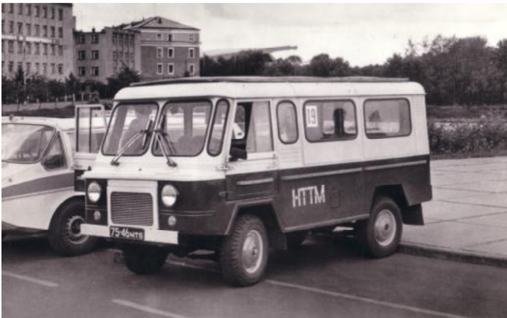
Автомобиль повышенной проходимости «Кентавр» (Москва) автор А.Машуков, фото О.Яременко Особенность конструкции: Кузов типа «Сафари» со съемным верхом и боковинами, колесная Формула – 4x4, мест – 7, двигатель – ВАЗ 2101, масса в снаряженном состоянии – 1200 кг, скорость – 110 км/час, расход топлива по шоссе составляет 11-11.5 л/на 100 км
